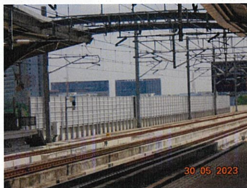
ภาพที่ 2-8 กำแพงกันเสียงเพื่อลดผลกระทบด้านระดับเสียง
