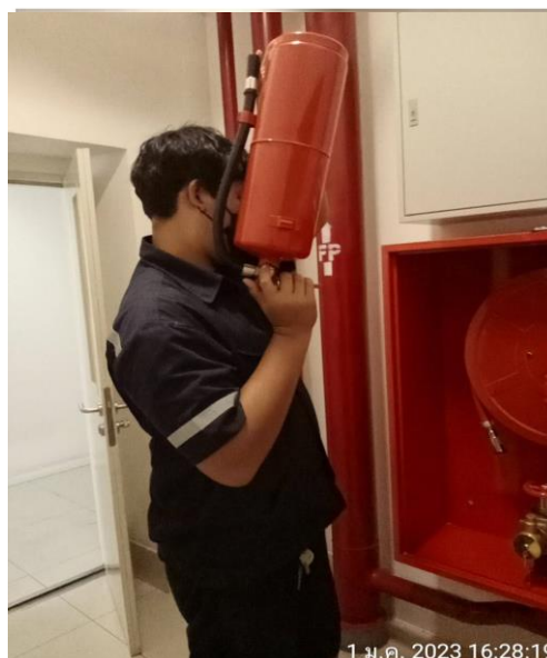
รูปภาพที่ 12 ภาพการตรวจสอบถัง ดับเพลิงประจำเดือน
