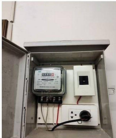
รูปภาพที่ 14 ภาพมิเตอร์ไฟฟ้าระบบ น้ำบาดำเสีย
