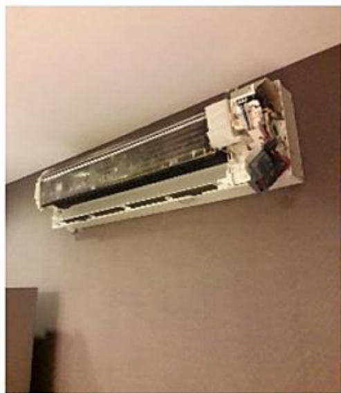
รูปภาพที่ 85 ภาพทำความสะอาดแผ่น กรองเครื่องปรับอากาศสำนักงาน
