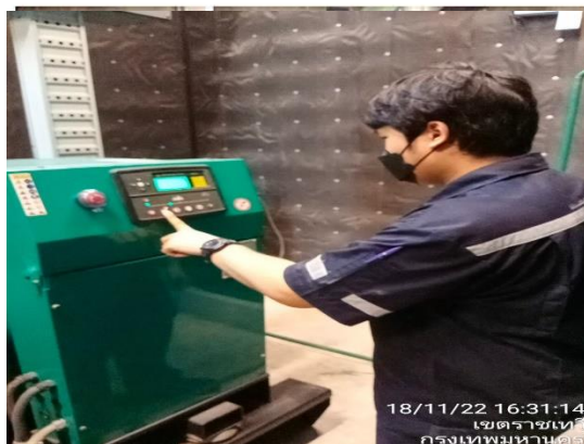
รูปภาพที่ 9 ภาพการทดสอบการทำงานของ เครื่องจ่ายไฟฟ้าสำรอง
