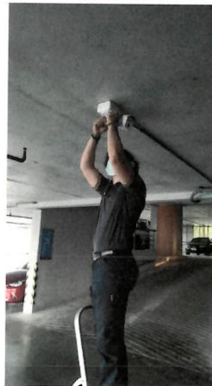
ภาพแสดงการตรวจสอบอุปกรณ์ความปลอดภัย และตรวจเช็คกล้องวงจรปิด
