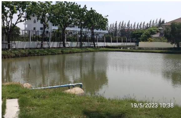
รูปที่ 2-14 บ่อหน่วงน้ำภายในพื้นที่โครงการ
