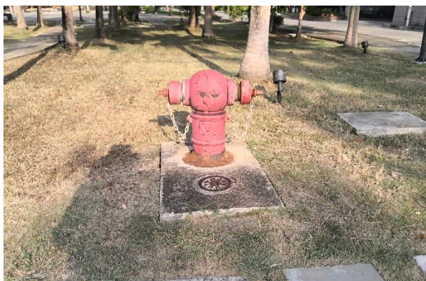
รูปที่ 2-21 ติดตั้งหัวจ่ายน้ำดับเพลิงให้ครอบคลุม พื้นที่ทั้งหมดของโครงการ
