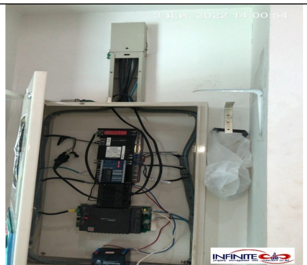
ภาคผนวกที่ 3.62 ตรวจสอบเช็คระบบ Lighting Control
