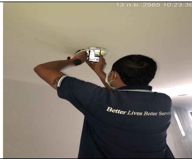
ภาคผนวกที่ 3.95 ตรวจสอบเชื้อราฝ้าเพดานห้องพักอาศัย
