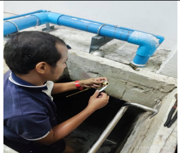
ภาคผนวกที่ 3.74 แก้ไขเปลี่ยนลูกลอยควบคุมโพลทวาล์วแทงค์น้ำใต้ดินอาคาร B
