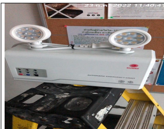
ภาคผนวกที่ 3.51 เปลี่ยนแบตเตอรี่ Emergency Light
