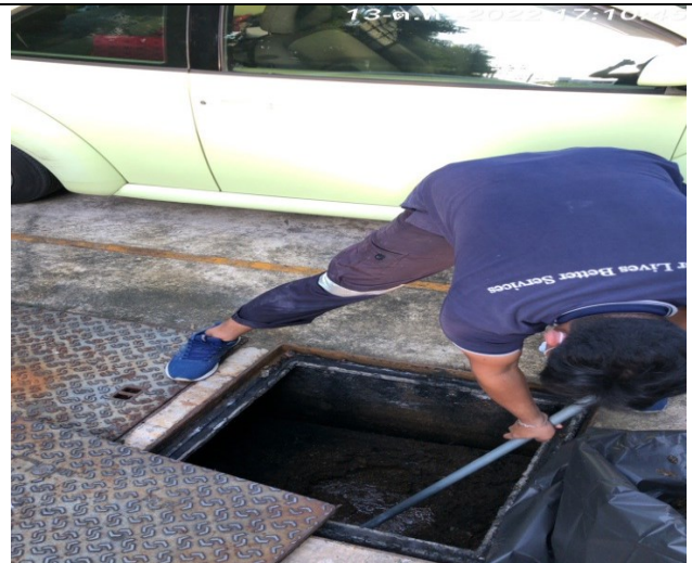
ภาคผนวกที่ 3.104 ตรวจเช็คน้ำเอ่อขึ้นท่อ Clean Out
