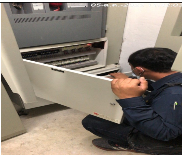
ภาคผนวกที่ 3.61 ตรวจสอบเช็คตู้ FCP
