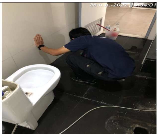
ภาคผนวกที่ 3.63 ตรวจสอบน้ำรั่วซึมบริเวณผนังภายนอก ห้องน้ำฟิตเนส
