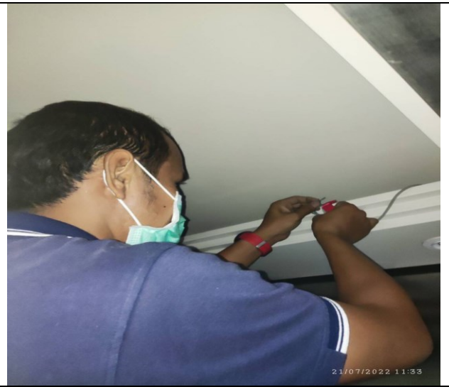
ภาคผนวกที่ 3.72 แก้ไขชุดโคมไฟ Ceiling Light ภายในลิฟท์
