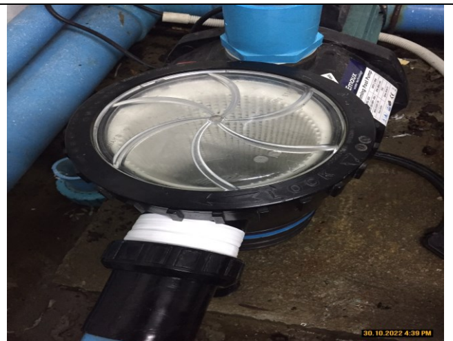
ภาคผนวกที่ 3.38 แก้ไขไล่อากาศปั๊มสระว่ายน้ำ
