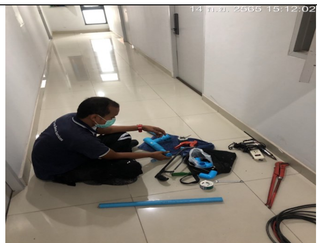
ภาคผนวกที่ 3.57 แก้ไขอุดรอยรั่วท่อน้ำดี
