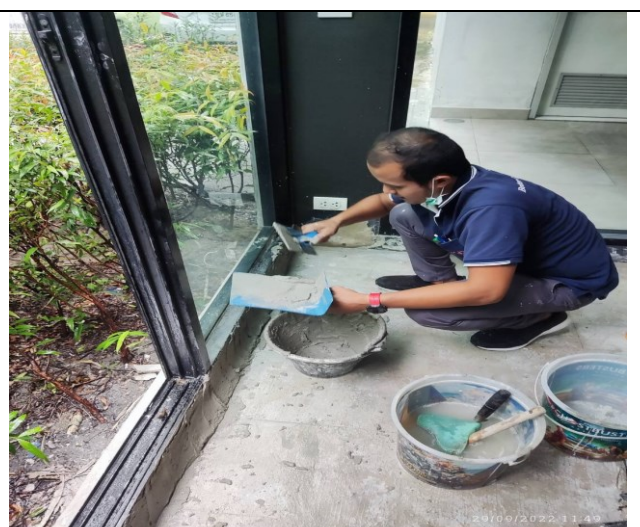
ภาคผนวกที่ 3.100 ฉาบปูนแก้ไขน้ำรั่วใต้หน้าต่างห้องฟิตเนส
