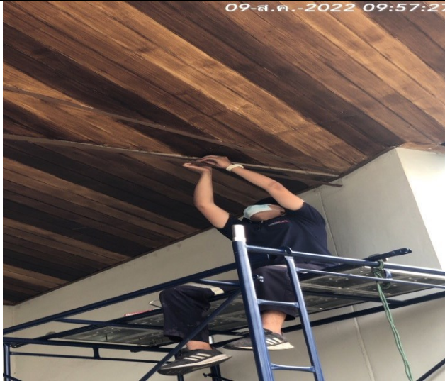
ภาคผนวกที่ 3.73 แก้ไขโครงเหล็กที่ครอบยึดฝ้าซุ้มทางลอดใต้อาคาร
