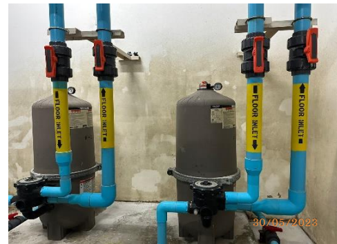
รูปที่ 3-58 ระบบกรองน้ำสระว่ายน้ำ
