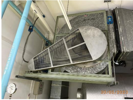
รูปที่ 3-71 พัดลมระบายอากาศ
