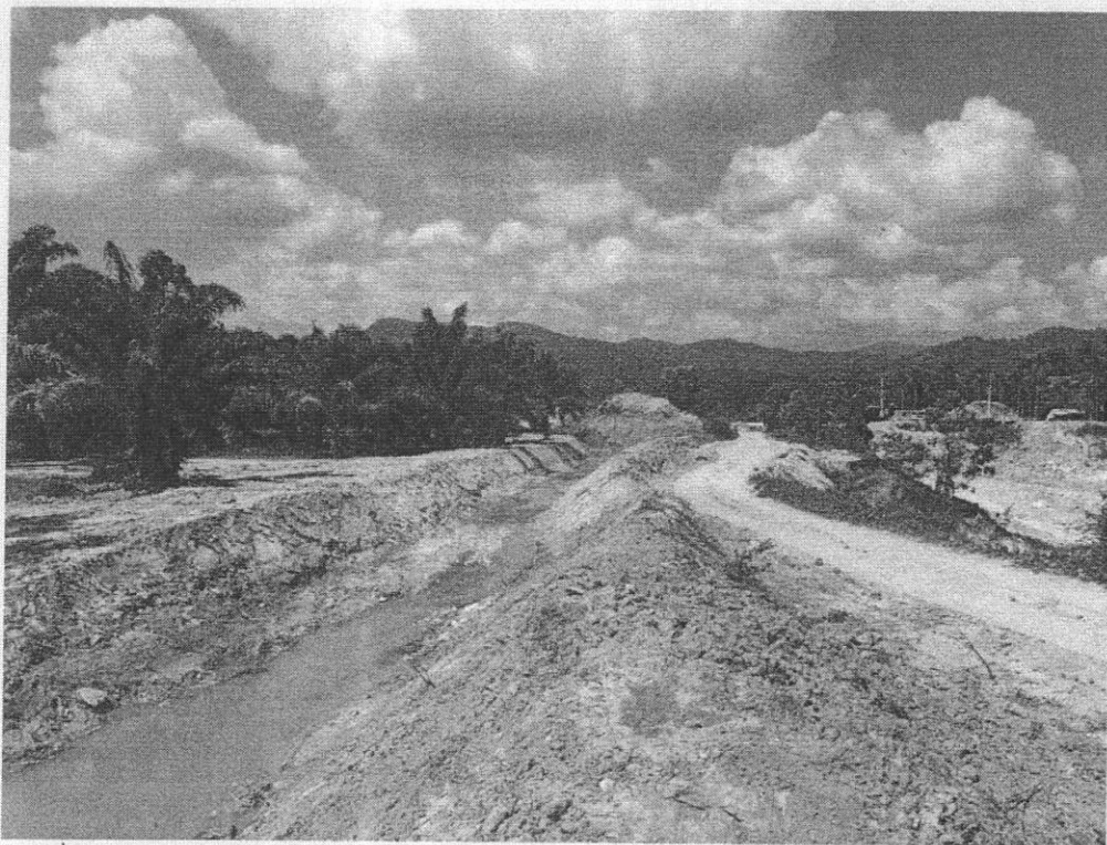
ภาพที่ 6 สภาพคลองสุญที่ติดกับบ่อเหมือง มีการขุดลอกและปรับแต่งให้อยู่ในสภาพให้น้ำไหลได้สะดวก
