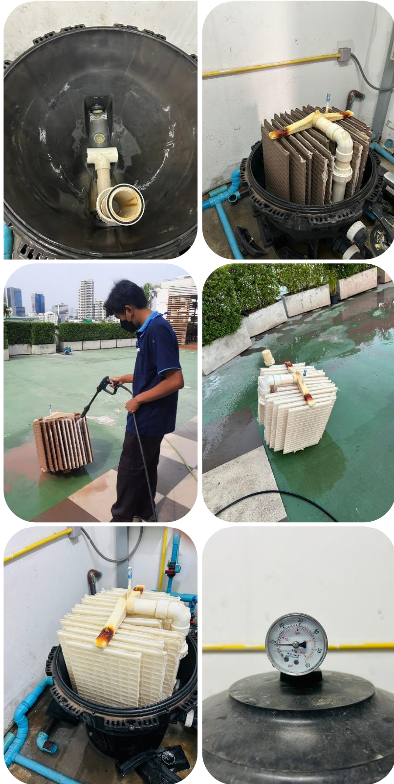
ภาพที่ 4.2-4 การทำความสะอาดถังกรองสวะน้ำ
