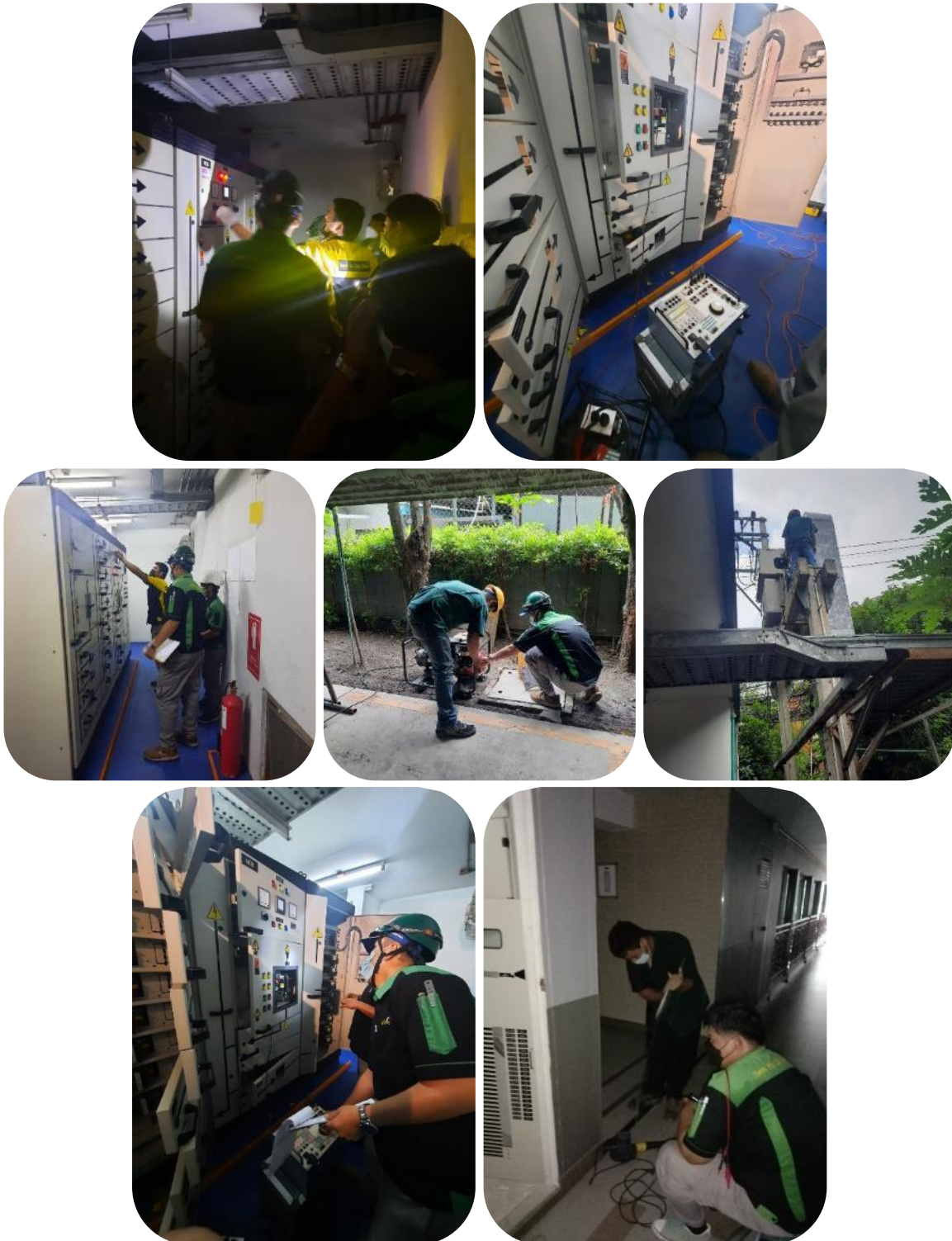
ภาพที่ 2-3.1.2 ตรวจสอบและบำรุงรักษาระบบไฟฟ้า หม้อแปลงไฟฟ้า และตู้ควบคุม MDB
