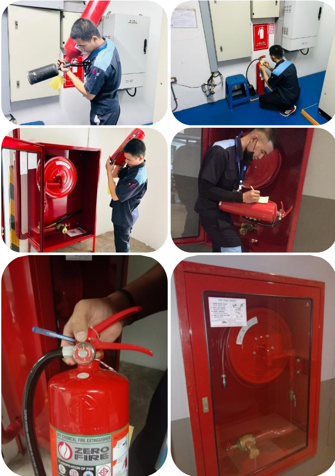
ภาพที่ 2-4.4(1) ตรวจเช็คตู้ดับเพลิง สายดับเพลิง และถังดับเพลิงประจำเดือน
