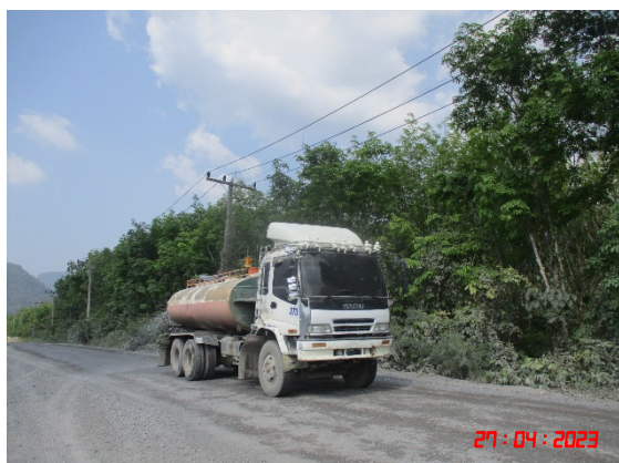
รูปที่ 13 การฉีดพรมน้ำในพื้นที่โครงการ
