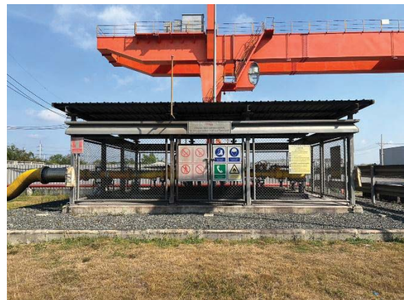
ภาพที่ 46 สถานีควบคุมความดัน และวัดปริมาณก๊าซ
