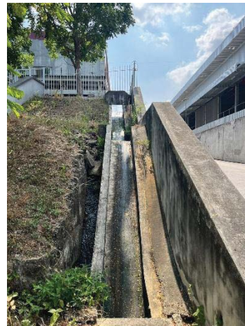
ภาพที่ 16 รางระบายน้ำฝนที่เชื่อมต่อกับระบบระบายน้ำฝนของนิคม
