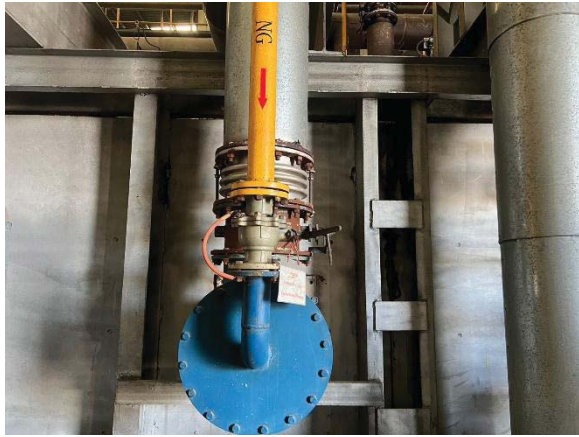
ภาพที่ 1 หัวเผาของเตาอบเหล็ก แบบ Ultra low NO x burners
