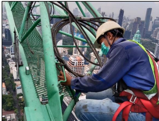
ภาพที่ 24 กิจกรรมหยอดน้ำมันหล่อลื่น
