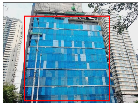
ภาพที่ 23 ติดกระจกอาคาร
