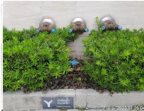
จุดเชื่อมต่อท่อประปาของการประปานครหลวง ภาพที่ 1.3.4-1 ระบบน้ำใช้
