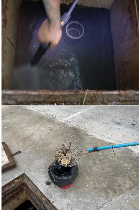
ภาพที่ 2.2-7 การตัดตะกอนจากบ่อดักไขมันและบ่อเกรอะ
