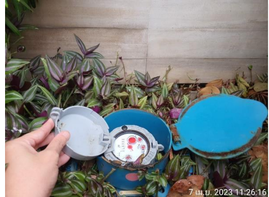
จุดเชื่อมต่อท่อประปาของการประปานครหลวง ภาพที่ 1.3.4-1 ระบบน้ำใช้
