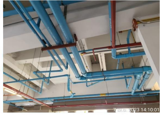
ท่อระบายน้ำภายในอาคาร
