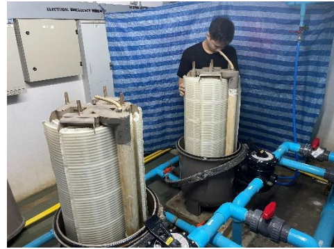
ล้างเครื่องกรองสรวายน้ำ ภาพที่ 2.2-28 เจ้าหน้าที่ดูแลสรวายน้ำ
