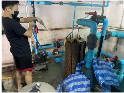
ล้างเครื่องกรองสรวายน้ำ ภาพที่ 2.2-28 เจ้าหน้าที่ดูแลสรวายน้ำ
