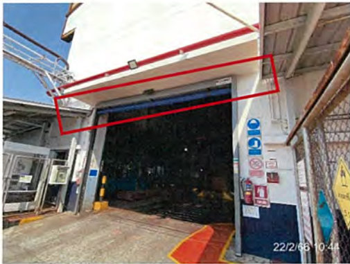
รูปที่ 14 การติดตั้งผ้าใบป้องกันเสียง บริเวณประตูโรงโหลดแผ่นทองแดง
