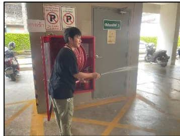
ภาพที่ 2.2-26 ตรวจสอบประสิทธิภาพของอุปกรณ์ระบบดับเพลิง
