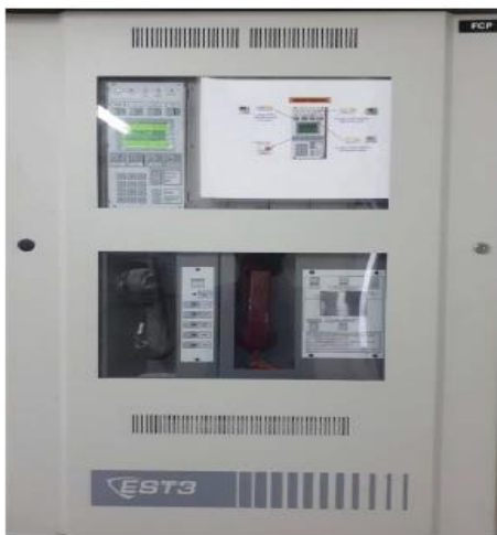
แผงควบคุมสัญญาณแจ้งเหตุเพลิงไหม้
