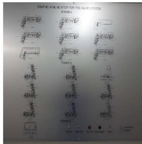
แผงควบคุมสัญญาณแจ้งเหตุเพลิงไหม้
