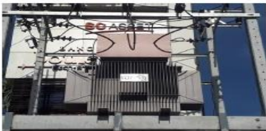
รูปภาพ 1.3.6-1,2 หม้อแปลงไฟฟ้า
