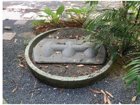
ภาพที่ 21 บ่อเกรอะ-กรองไร้อากาศ เพื่อรองรับน้ำเสียจากอาคารห้องพัก
