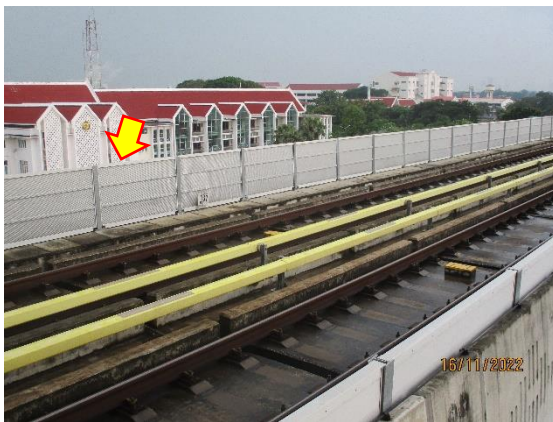
รูปที่ 2-3 ติดตั้งกำแพงกันเสียงสูง 1.20 เมตร ตลอดสองข้างทางของรางรถไฟฟ้า
