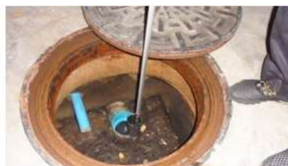
1.1 บ่อเก็บจุดเก็บตัวอย่างน้ำเสียเข้าระบบ (Influent) เนื่องจากเครื่องเดิมชากเสีย ทำให้น้ำเสียครั้งนี้ มีสภาพเหลือง-ขุ่น และมีค่า BOD สูงขึ้นกว่าปกติ
