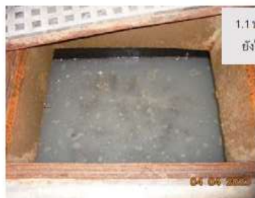
1.2 บ่อเกอระ จุดเก็บตัวอย่างน้ำเสียเข้าระบบ มีกากตะกอนสะสมอยู่ค่อนข้างมาก ควรเช็คความหนาแน่นของชั้นตะกอน เพื่อเตรียมการ สูบลากตะกอน ออกจากระบบบ้าง
