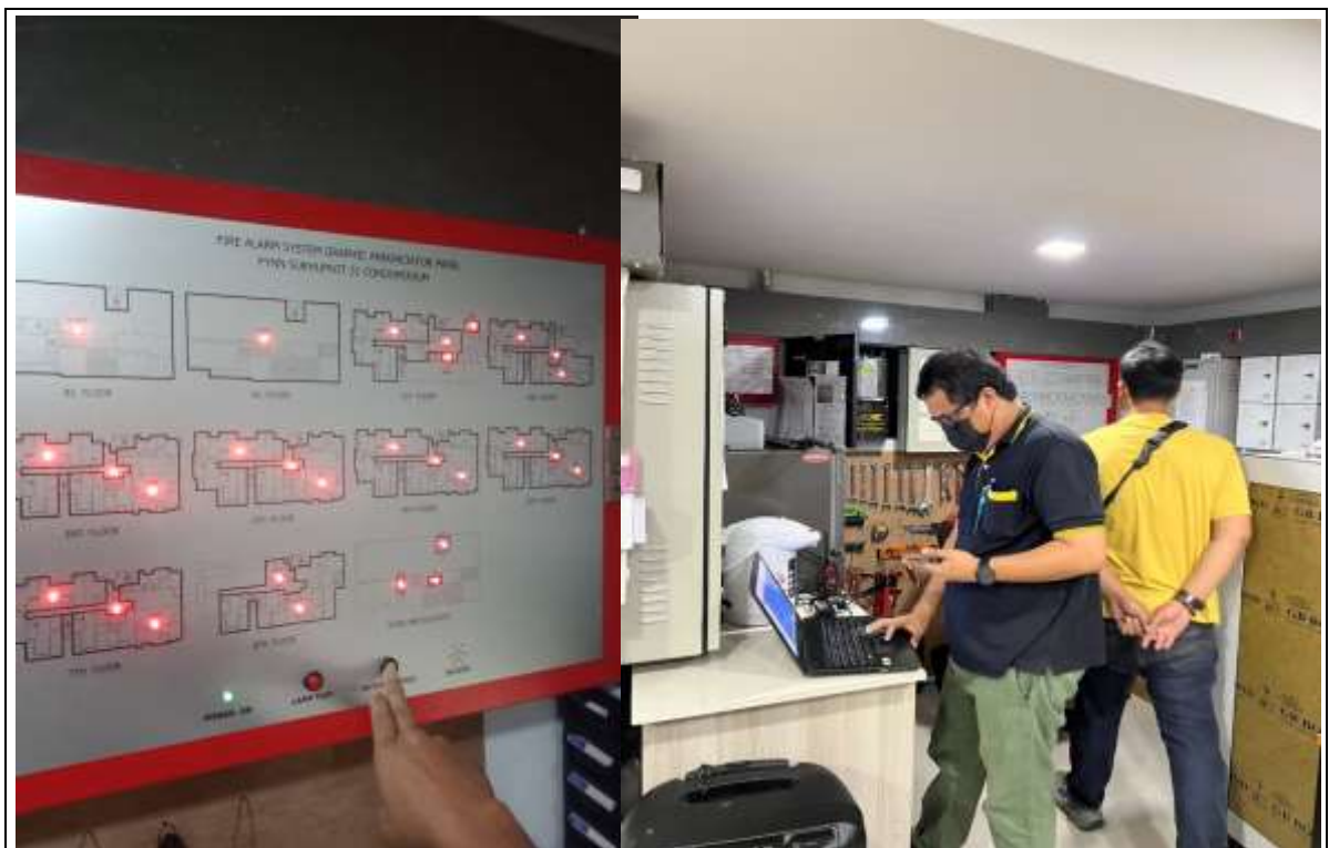
ภาคผนวกที่ 3-28 จัดให้มีการซ้อมบำรุงอุปกรณ์ป้องกันและสัญญาณเตือนอัคคีภัย
