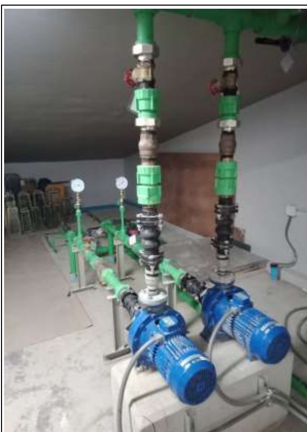
ภาคผนวกที่ 3-9 ท่อส่งน้ำ และระบบจ่ายน้ำประปา
