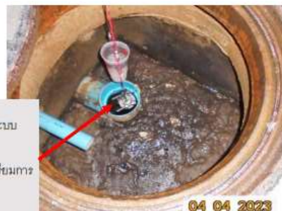
1.1 บ่อคักโสมริน สภาพเป็นน้ำเสียสีขาว-ขุ่น ยังไม่ต้องเคลียร์กากโสมริน เพราะยังน้อย
