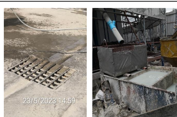
ภาพที่ ก-34 ท่อระบายน้ำและบ่อดักตะกอนดิน
