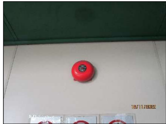
รูปที่ 2-38 การติดตั้งอุปกรณ์เตือนภัยกรณีเกิดเหตุฉุกเฉิน บริเวณสถานี E10-E14
