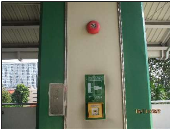
รูปที่ 2-38 การติดตั้งอุปกรณ์เตือนภัยกรณีเกิดเหตุฉุกเฉิน บริเวณสถานี E10-E14
