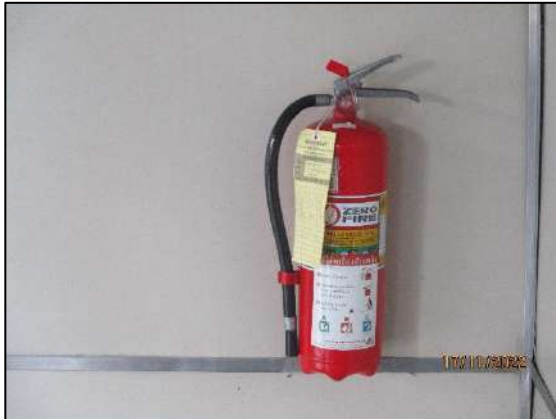
รูปที่ 2-16 (ต่อ) การติดตั้งอุปกรณ์ดับเพลิง บริเวณสถานี S7-S8
