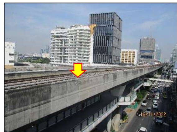
รูปที่ 2-21 กำแพงกันเสียงสูง 1.20 เมตร ตลอดสองข้างทางของรางรถไฟฟ้า บริเวณสถานี E10-E14
