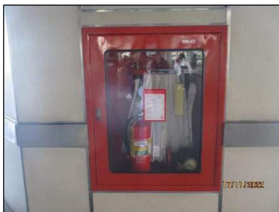
รูปที่ 2-16 การติดตั้งอุปกรณ์ดับเพลิง บริเวณสถานี S7-S8
