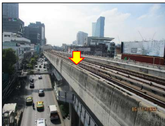
รูปที่ 2-21 กำแพงกันเสียงสูง 1.20 เมตร ตลอดสองข้างทางของรางรถไฟฟ้า บริเวณสถานี E10-E14
