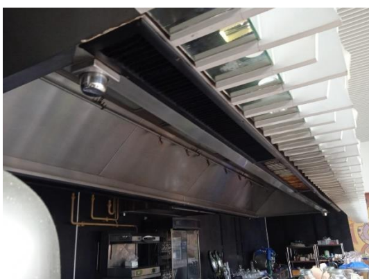
ภาพที่ 29 เครื่องดูดควันและกลิ่นในห้องครัว
