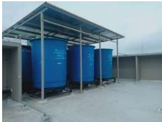
รูปที่ 14 ถังเก็บน้ำสำรอง
