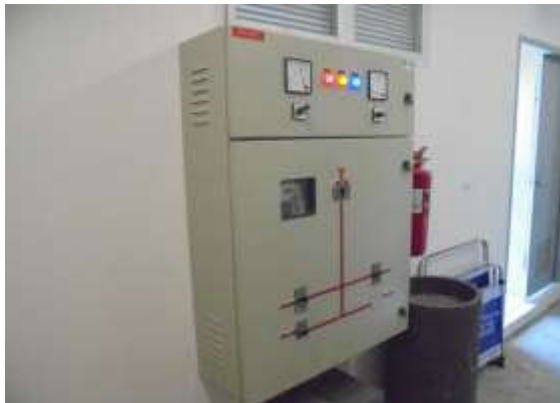
รูปที่ 13 ระบบมิเตอร์ไฟฟ้าสำหรับระบบบำบัดน้ำเสีย
