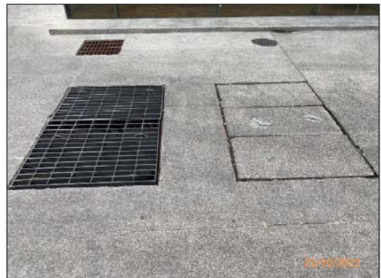
ภาพที่ 2.2-7 ตะแกรงดักเศษขยะที่บ่อพักน้ำสุดท้าย
