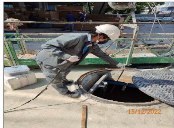
การเก็บตัวอย่างคุณภาพน้ำบริเวณบ่อพักน้ำชั่วคราว ก่อนระบายลงสู่ท่อระบายน้ำสาธารณะ
