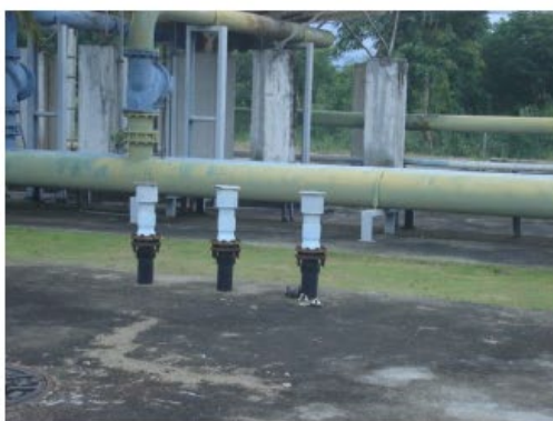
จ. เครื่องเติมอากาศแบบ Air Blower
