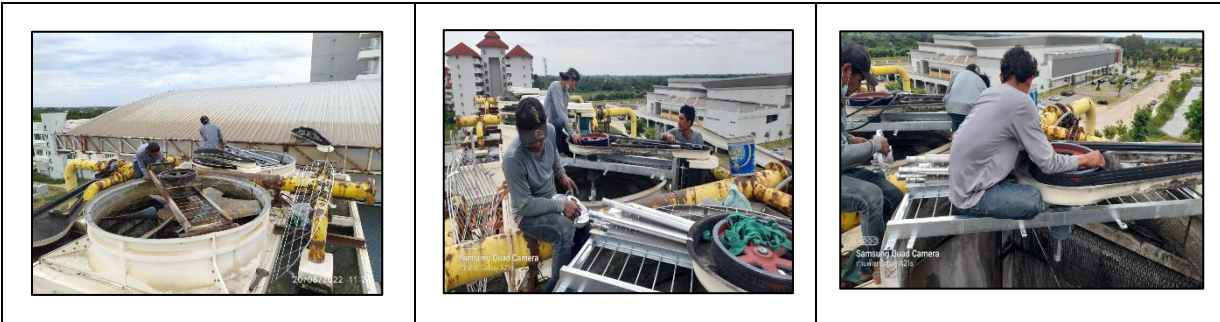
ภาพที่ ค-10 บำรุงรักษาหอระบายความร้อนระบบปรับอากาศ ระหว่างเดือนกรกฎาคม - ธันวาคม 2565
