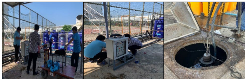
ภาพที่ 3-33 การตรวจสอบการทำงานของเครื่องเติมอากาศและมีปรับปรุงระบบบำบัดน้ำเสีย
