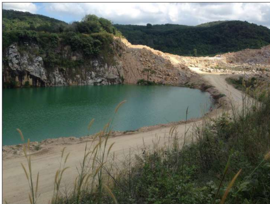
ภาพถ่าย แสดงบ่อดักตะกอนขนาดใหญ่บริเวณหน้าเหมือง
