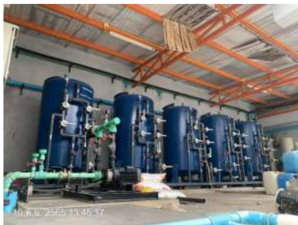
รูปที่ 8 ระบบปรับปรุงคุณภาพน้ำภายในโครงการ
