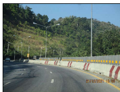
แผงกันแสงไฟหน้ารถบริเวณ เกาะกลางแบบ Concrete Barrier
