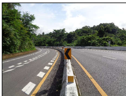
สภาพผิวจราจร และเส้น Optical Speed Bar Rumble Strips กม.360+100 (เดิม กม.140+178)
