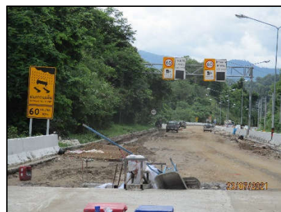
บริเวณที่อยู่ระหว่างปรับปรุงผิวทางเป็นคอนกรีตเสริมเหล็ก
