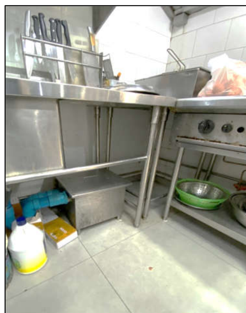
ภาพที่ 36 แสดงบ่อดักไขมันภายในห้องครัว
