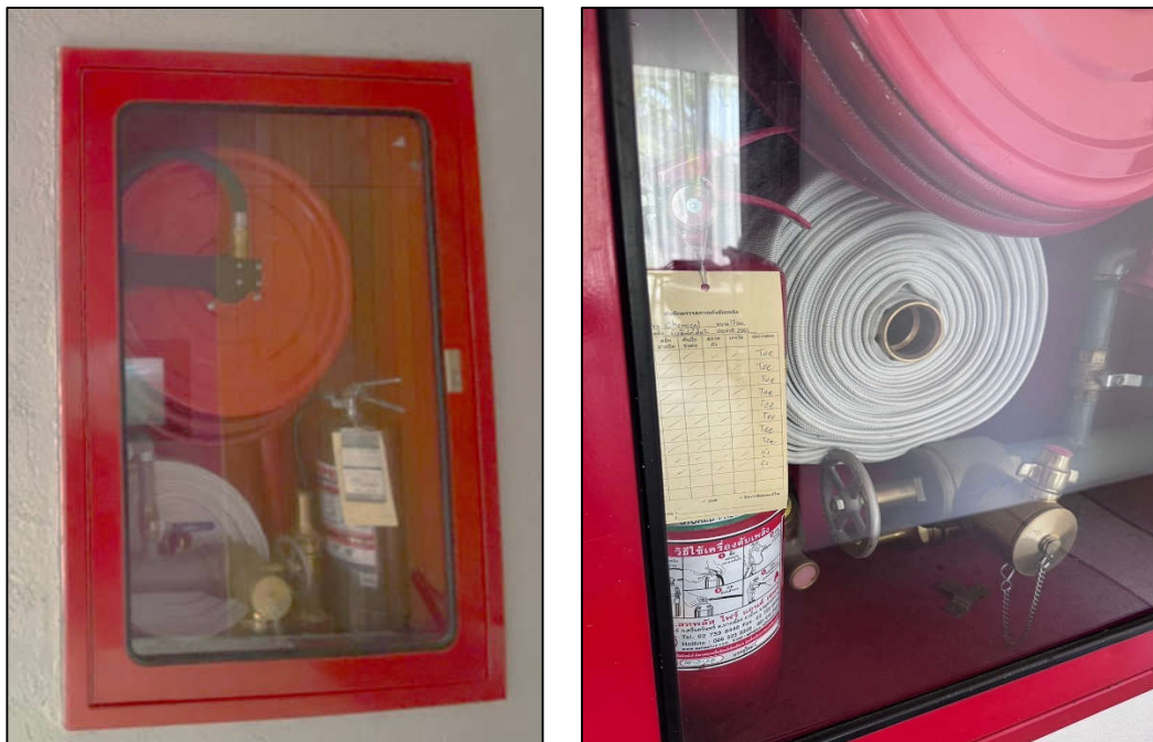
ภาพที่ 27 แสดงตู้อุปกรณ์ดับเพลิง & วิธีการใช้งาน
