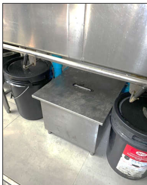
ภาพที่ 36 แสดงบ่อดักไขมันภายในห้องครัว
