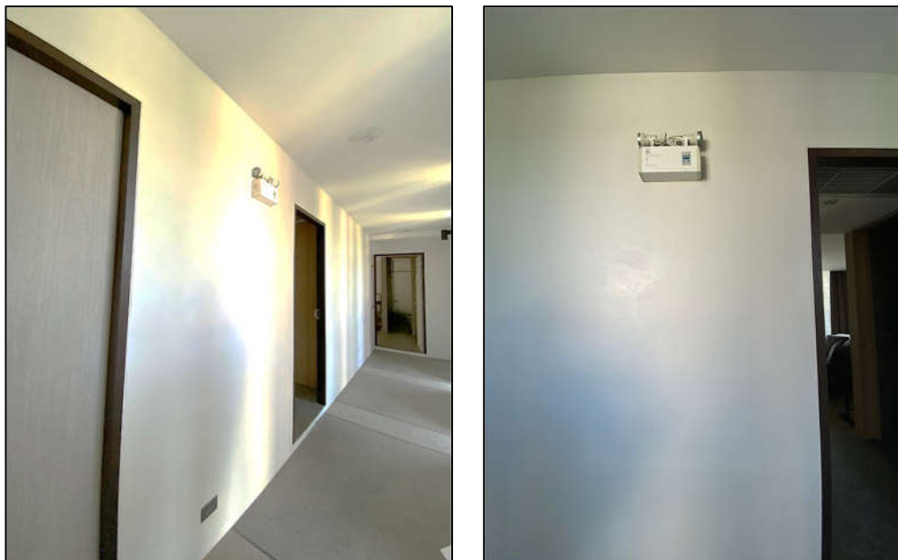
ภาพที่ 25 แสดงไฟส่องสว่างฉุกเฉิน
