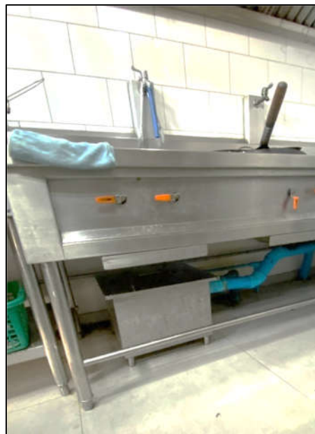
ภาพที่ 35 แสดงถังขยะ, บ่อดักไขมันภายในห้องครัว
