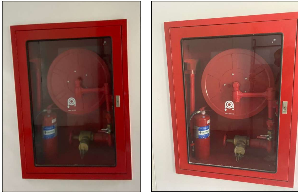
ภาพที่ 19 แสดงตู้เก็บสายน้ำดับเพลิง-ถังดับเพลิง
