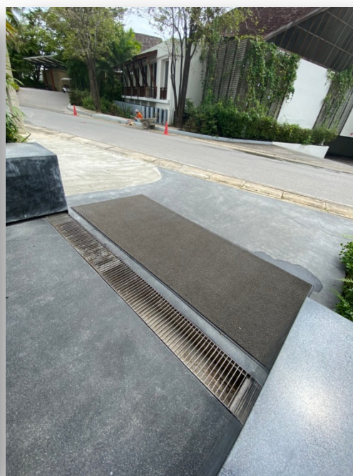
ภาพที่ 16 และ 17 แสดงตะแกรงดักมูลฝอย
