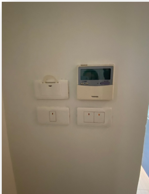
ภาพที่ 40 แสดง Key Card ควบคุมการเปิด/ปิด
