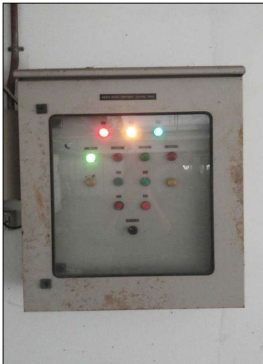
ภาพที่ 49 แสดงตู้คอนโทรลควบคุมการทำงานของเครื่องเติมอากาศ
