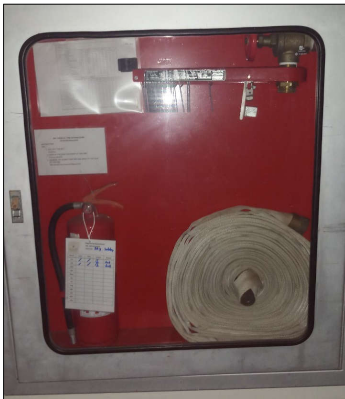
ภาพที่ 27 แสดงตู้เก็บสายน้ำดับเพลิง-ถังดับเพลิง
