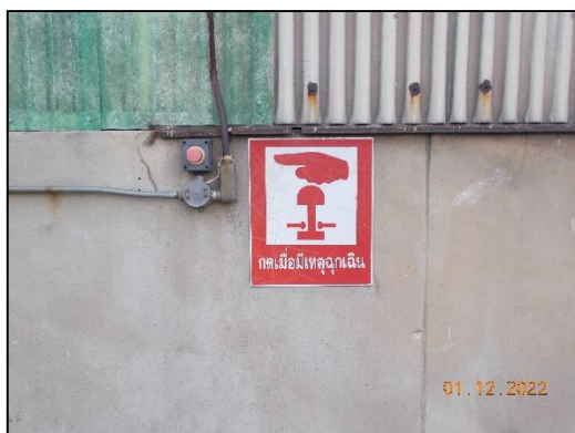
ภาพที่ 12 การติดตั้งปุ่มกดฉุกเฉิน
