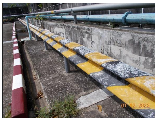
ภาพที่ 9 การติดตั้งราวเหล็กกันชน
