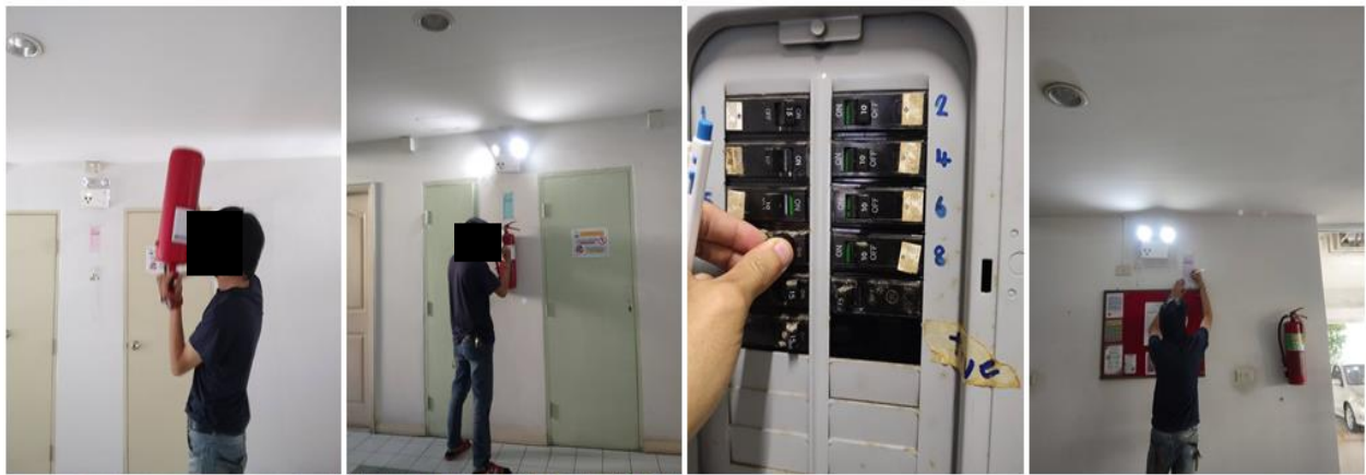
ช่างอาคารฯ ดำเนินการตรวจเช็คไฟฉุกเฉินและตรวจเช็คถังดับเพลิงประจำเดือน
