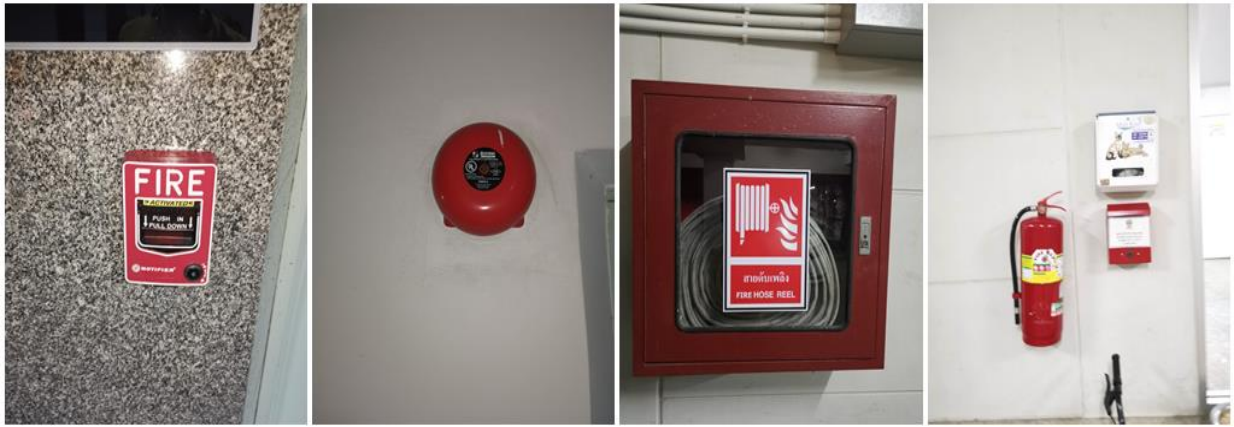
ถังดับเพลิงแบบมือถือ , อุปกรณ์แจ้งเหตุด้วยมือ, อุปกรณ์แจ้งเหตุเตือนภัย , ตู้ดับเพลิง
