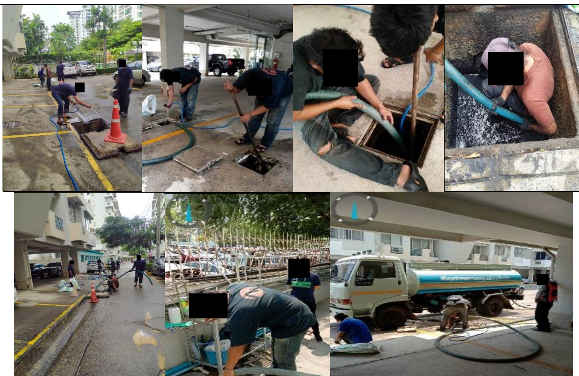
สับตะกอนระบบบำบัดน้ำเสียและลอกทางระบายน้ำของโครงการ
