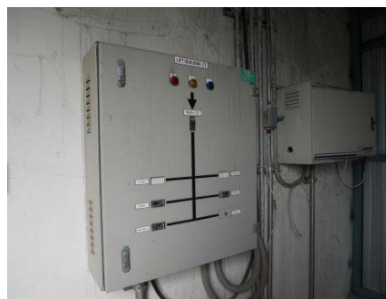
แผงควบคุมระบบบำบัดน้ำเสีย
