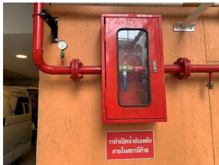
วาล์วเปิดน้ำดับเพลิงภายในสถานีก๊าซ
