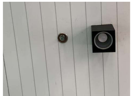
หัวฉีดน้ำ (Sprinkler)
