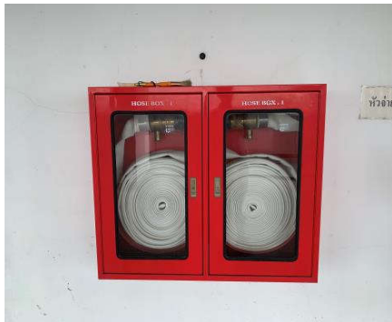
ตู้เก็บสายฉีดน้ำดับเพลิงพร้อมอุปกรณ์ (FHC)
