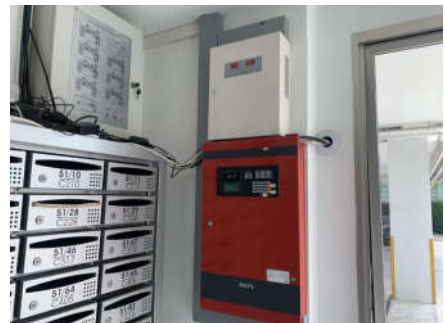
แผงควบคุมระบบดับเพลิง
