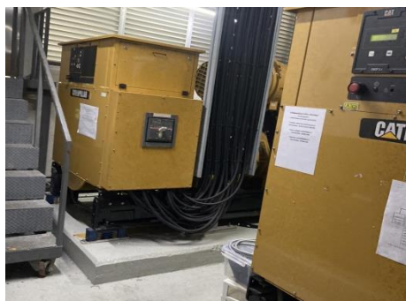
ภาพที่ 2.2-48 การติดป้ายชื่อสถานที่ติดต่อหรือเบอร์โทรศัพท์ติดต่อไว้บริเวณเครื่องกำเนิดไฟฟ้าสำรอง
