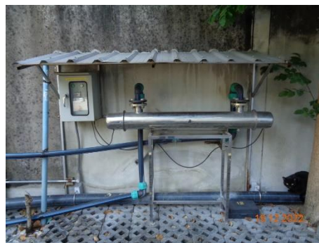
ภาพที่ 2.2-17 ระบบฆ่าเชื้อโรคในน้ำทั้งด้วยวิธี UV
