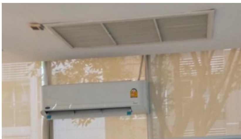
งานเปลี่ยนเครื่องปรับอากาศเป็นแบบINVERTER 2 เครื่อง
