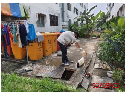
บ่อเกรอะระบบบำบัดน้ำเสียประจำอาคาร (A1) (อาคาร 3)
