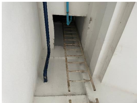
ภาพที่ 12 ถังน้ำสำรองชั้นใต้ดินและชั้นดาดฟ้าอาคารรูปแบบ A2
