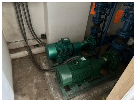
ภาพที่ 41 เครื่องสูบน้ำจากถังเก็บน้ำชั้นใต้ดินไปยังถังเก็บน้ำชั้นดาดฟ้า
