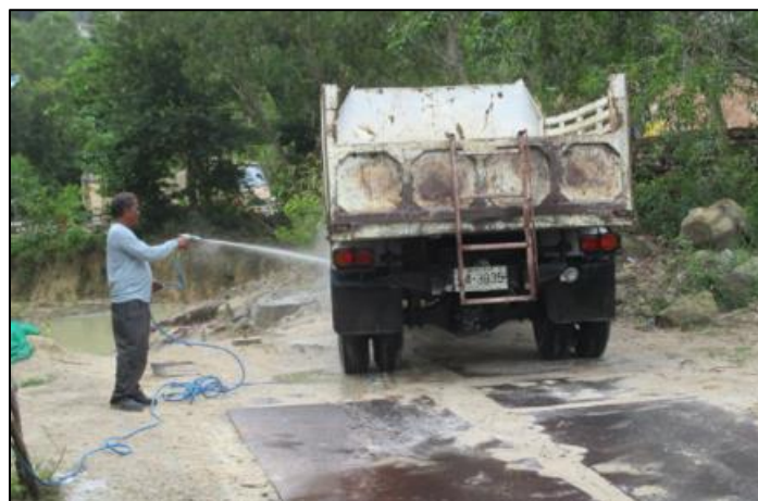
ภาพถ่าย ค.1-8 จุดล้างล้อรถ และการล้างล้อรถก่อนออกจากพื้นที่ก่อสร้าง
