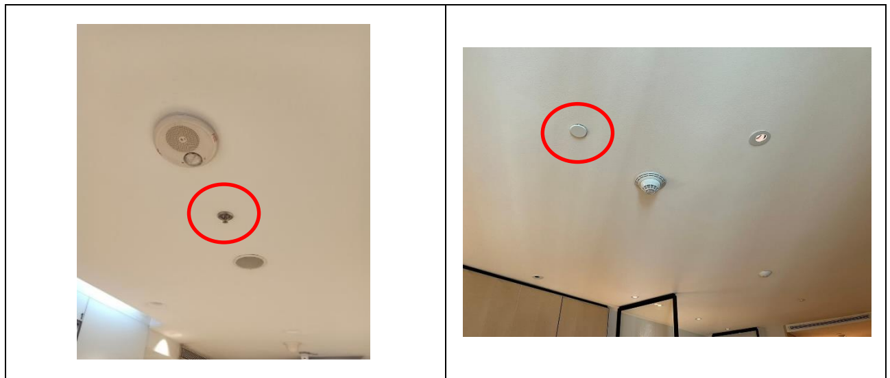
รูปที่ 2.26 หัวกระจายน้ำดับเพลิงอัตโนมัติ
