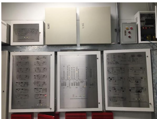
รูปที่ 2.53 แผงควบคุม (Fire Alarm Control Panel : FCP)
