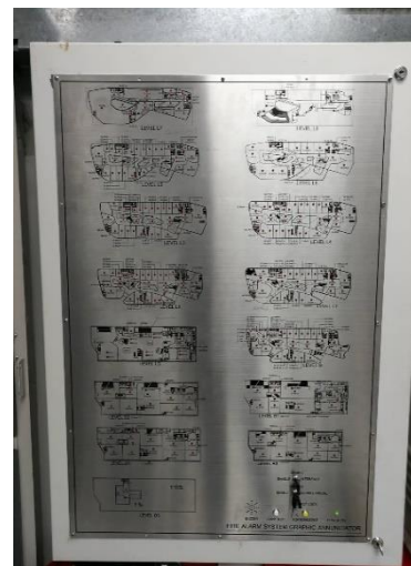
รูปที่ 2.53 แผงควบคุม (Fire Alarm Control Panel : FCP)
