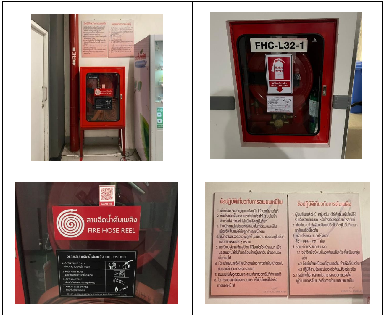
รูปที่ 2.19 ตู้ FHC พร้อมป้ายแนะนำการใช้งาน
