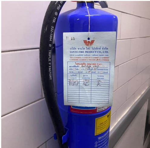
รูปที่ 2.21 การตรวจสอบถังดับเพลิง
