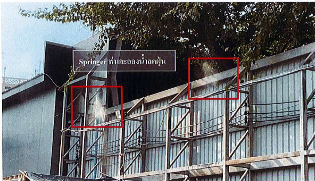
ภาพถ่ายที่ 4 sprinkler สเปรย์น้ำบนแนวรั้วรอบพื้นที่ก่อสร้าง
