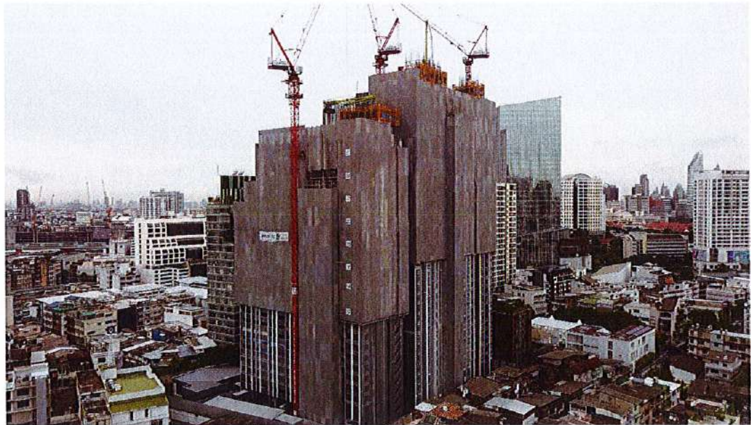
ภาพถ่ายที่ 7 ติดตั้งผ้าใบหรือ Mash Sheet ปิดคลุมรอบอาคาร
