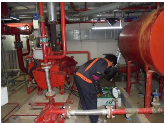
ภาพที่ 4-37 ตรวจสอบการทำงานของระบบ Fire Pump
