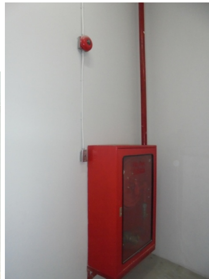
ภาพที่ 4-26 หัวรับน้ำดับเพลิงและตู้เก็บสายฉีดน้ำดับเพลิง
