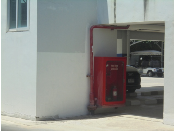
ภาพที่ 4-26 หัวรับน้ำดับเพลิงและตู้เก็บสายฉีดน้ำดับเพลิง
