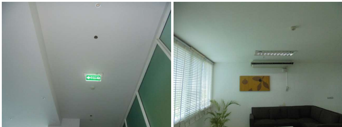
ภาพที่ 4-31 Smoke Detector และHeat Detector
