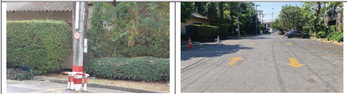
รูปที่ 2-2 การติดตั้งป้ายจำกัดความเร็ว และส่นชะลอความเร็วในพื้นที่โครงการ
