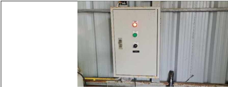
รูปที่ 2-7 การติดตั้งตู้ควบคุมระบบบำบัดน้ำเสีย
