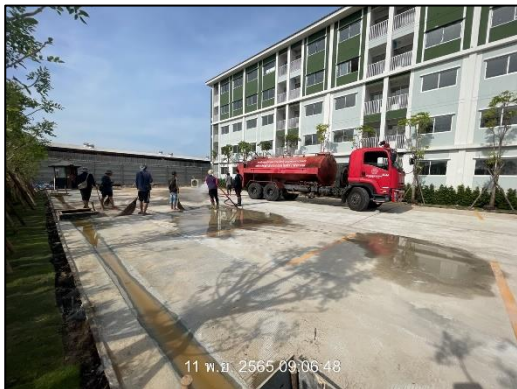
ภาพที่ 19 รางระบายน้ำรอบพื้นที่โครงการและกิจกรรมการทำความสะอาดรางระบายน้ำ
